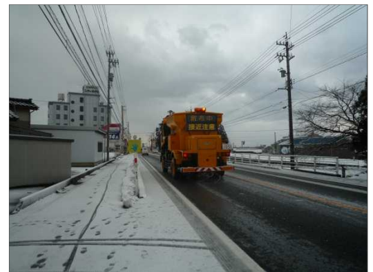
薬剤散布作業の様子
