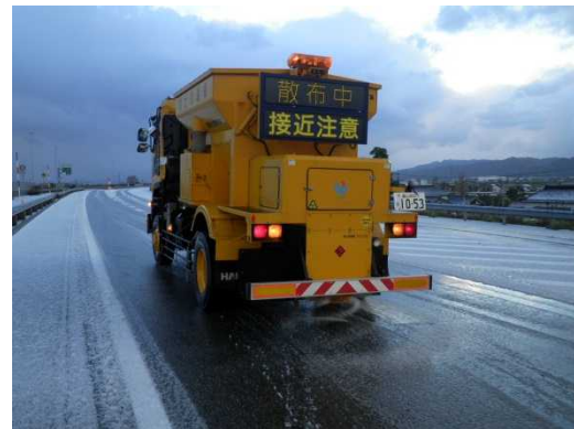
国道470号高岡市池田地先における作業状況
