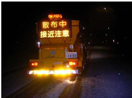
国道160号氷見市阿尾地先における作業状況
