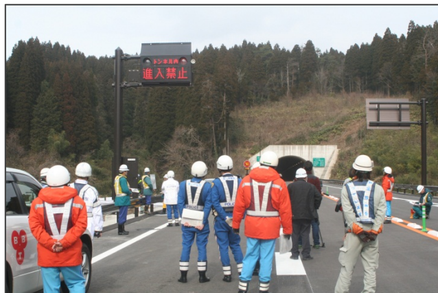
トンネル情報板の動作確認
