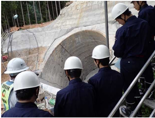
斜め深礎杭の見学
