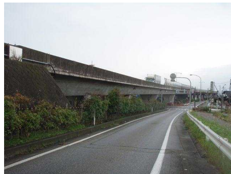
国道8号 金泉寺高架橋
