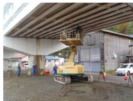
高所作業車を用いた点検(例)
