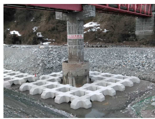
〈根固めブロック設置〉
