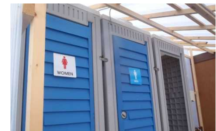
工事現場のトイレとしては珍しい男女別に設置された水洗トイレ
