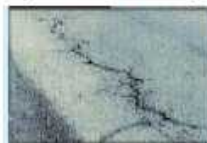
舗装のひび割れ
