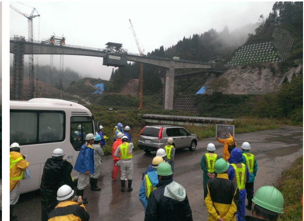
下島大橋上部工の施工状況
