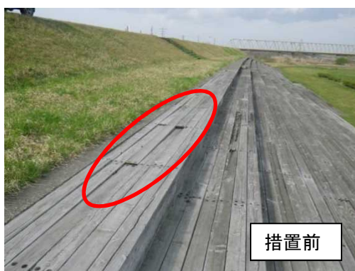
庄川⑪: 砺波市柳瀬 砺波総合運動公園 破損した木製階段の補修
