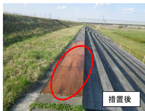
庄川⑪: 砺波市柳瀬 砺波総合運動公園 破損した木製階段の補修
