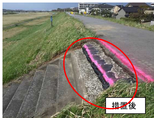
神通川⑪: 富山市中神通 管理用通路 アスファルト補修材による補修
