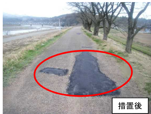
神通川⑪: 富山市中神通 管理用通路 アスファルト補修材による補修
