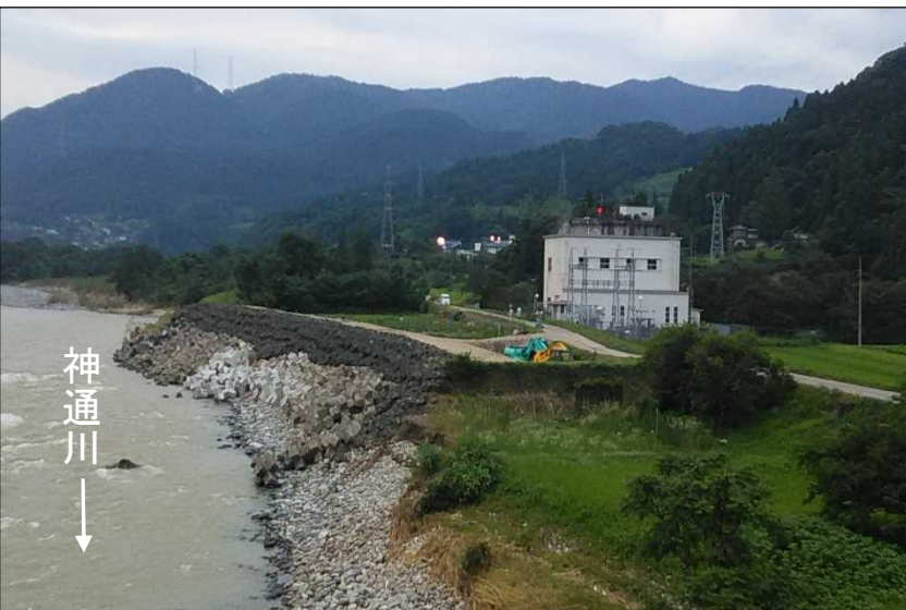
復旧が完了した堤防 (平成30年7月11日 18時30分)
