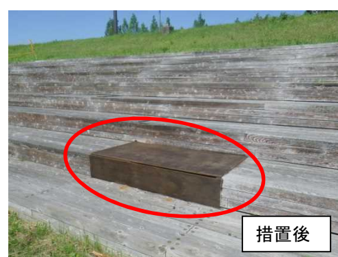
庄川_11:砺波市柳瀬 砺波総合運動公園 破損した木製階段の張替え
