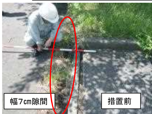
神通川_1:富山市五福 階段工 川裏階段の隙間部分のモルタル間詰め
