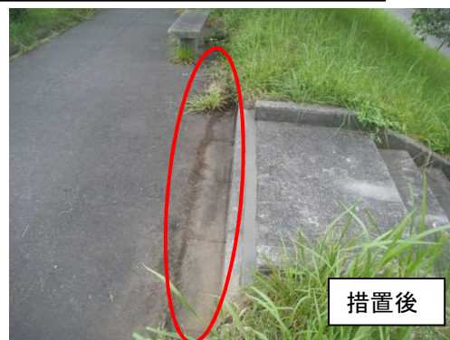
神通川_1:富山市五福 階段工 川裏階段の隙間部分のモルタル間詰め
