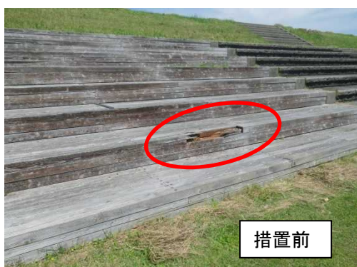
庄川_11:砺波市柳瀬 砺波総合運動公園 破損した木製階段の張替え
