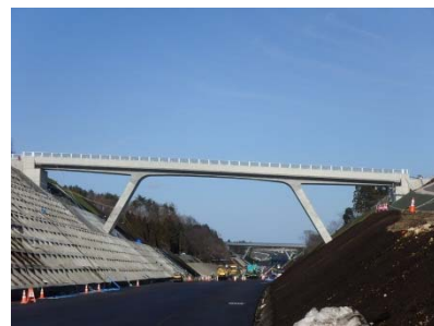
完成間近の中波跨道橋
