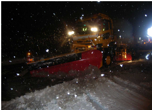
国道8号滑川市大掛地先における作業状況
