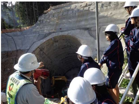
斜め深礎杭の見学
