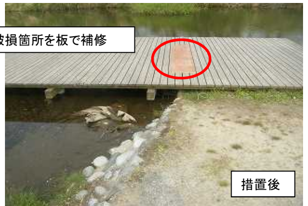
神通川⑪: 富山空港向いの、低水護岸通路の舗装剥離箇所を穴埋め
