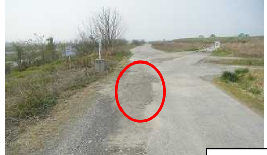
神通川⑪: 富山空港向いの、低水護岸通路の舗装剥離箇所を穴埋め
