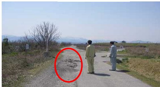
神通川⑪: 富山空港向いの、低水護岸通路の舗装剥離箇所を穴埋め
