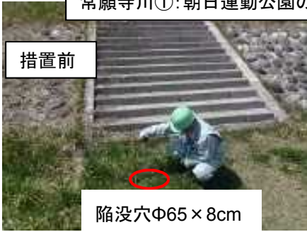
常願寺川①: 朝日運動公園の、階段付近の陥没箇所を穴埋め
