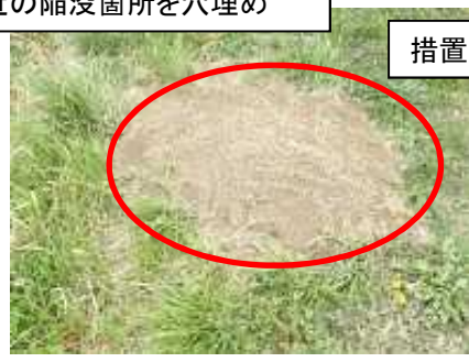
常願寺川①: 朝日運動公園の、階段付近の陥没箇所を穴埋め
