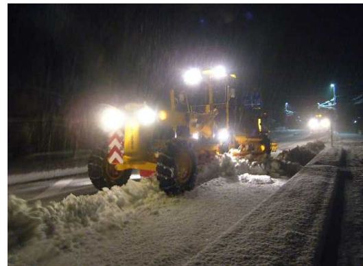
国道156号砺波市庄川町小牧地先における作業状況
