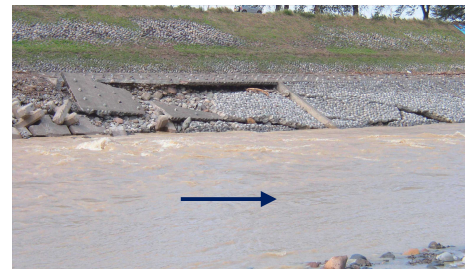
堤防護岸欠壊及び根固流出
