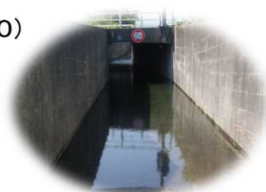
冠水した道路の事例
