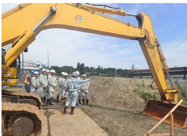
MGバックホウによる 盛土法面整形の見学
