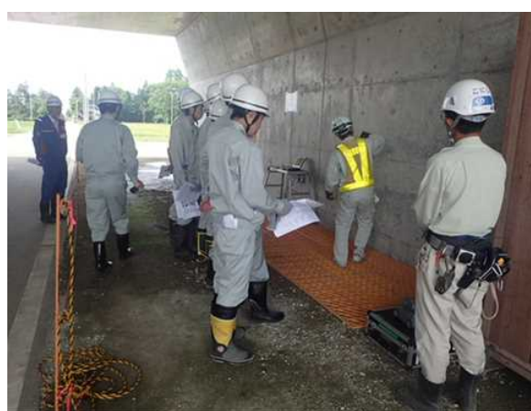
コンクリート構造物 非破壊試験の体験
