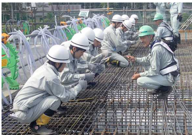
鉄筋組立の体験
