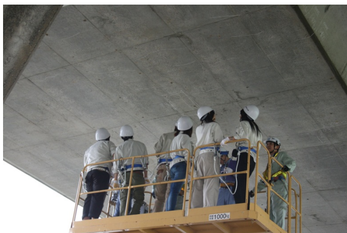
橋梁点検車に乗り、近接目視点検を実施
