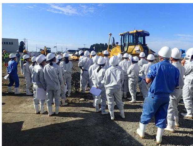
MCブルドーザの見学 (砺波東バイパス)
