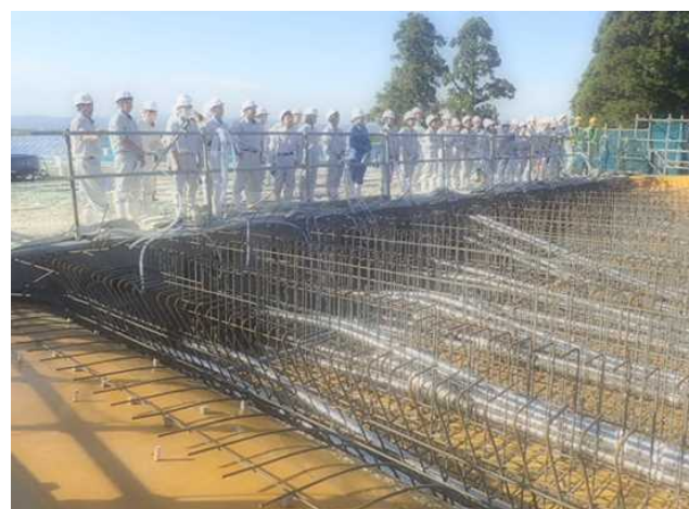
上部工施工状況の見学 (砺波東バイパス)
