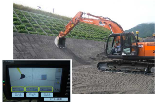
ICTを活用した土工工事の施工状況
