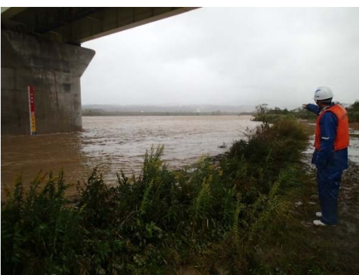
橋梁状況確認 となみ野大橋 （庄川左岸18.8k）砺波市柳瀬
