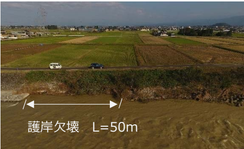
（井田川右岸12.4k）富山市八尾町井田
