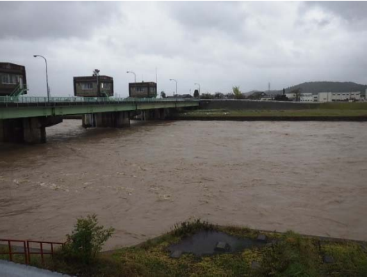
小矢部大堰状況確認（小矢部川35.0k） 小矢部市鴨島
