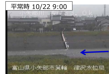
出水状況 小矢部川左岸33.0k付近
