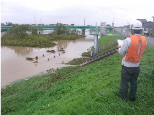
二上第一樋管状況確認（小矢部川左岸5.8k） 高岡市守護町
