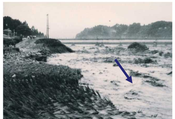
常願寺川 岩嶺寺地先の洗掘による破堤状況 （昭和44年8月11日洪水）
