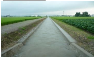
水路の改修（大断面化）
