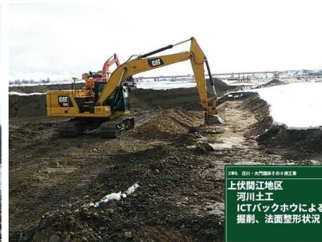
ICTバックホウによる法面整形状況
