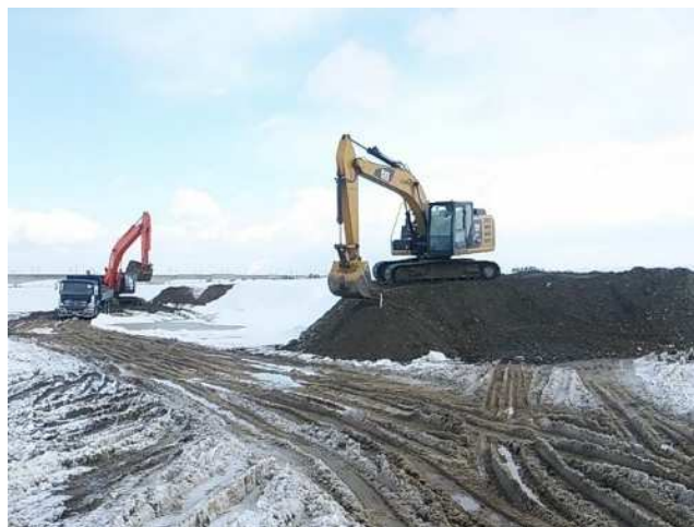
仮締切造成状況
