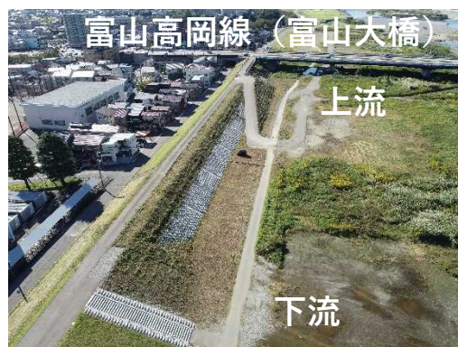
【安野屋地区 着手前】
