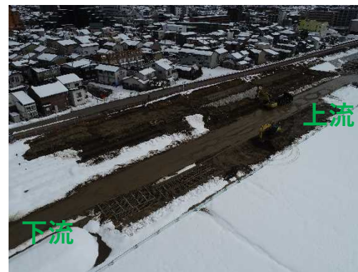
【布瀬地区 盛土施工中】
