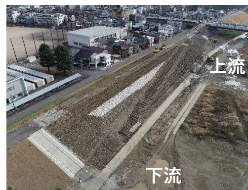
【安野屋地区 盛土完了】
