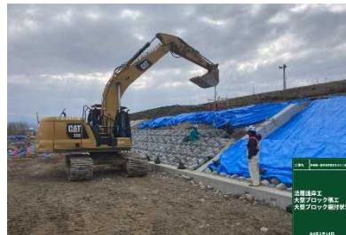
大型ブロック据付状況
