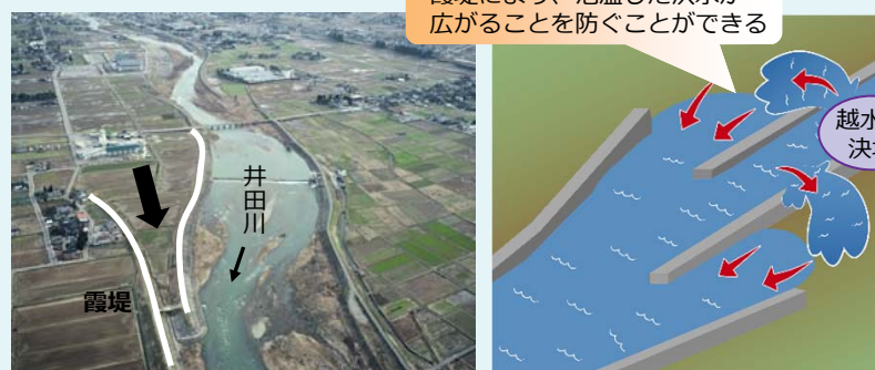
井田川の霞堤（富山市八尾町高善寺）
