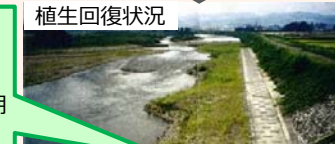
護岸前面の覆土による植生の早期回復事例
