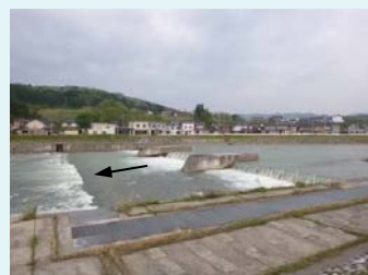
大坪用水堰 (富山市八尾町福島)
