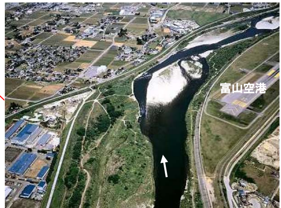
写真 3-18 神通川 14.0k 付近の状況
