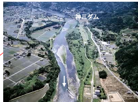
写真 3-14 神通川 23.4k 付近の状況
