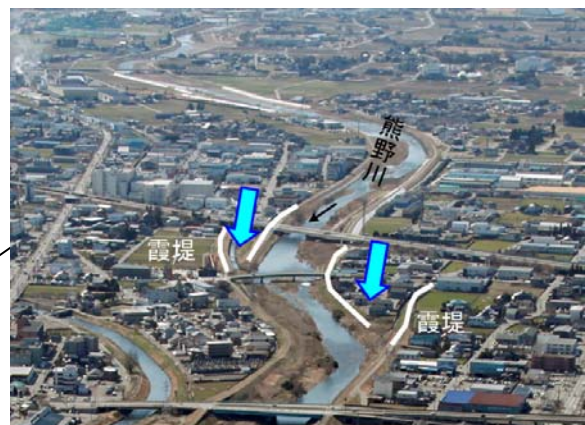
写真 3-6 熊野川 1.0k 付近の霞堤
