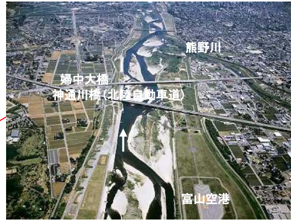
写真 3-17 神通川 11.0k 付近の状況
