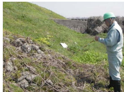
写真 5-8 堤防の点検
