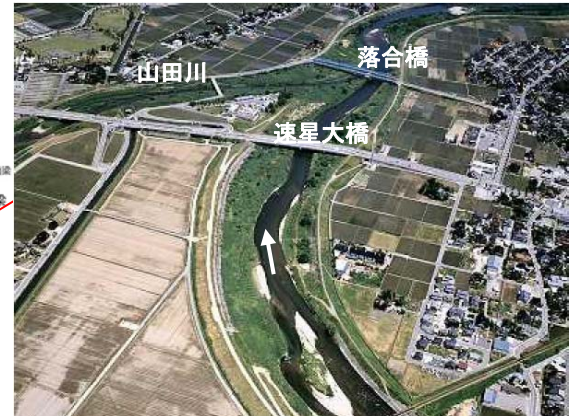
写真 3-25 井田川の 6.0k 付近の状況
