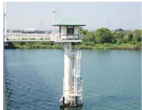
写真 5-5 萩浦橋水位観測所
