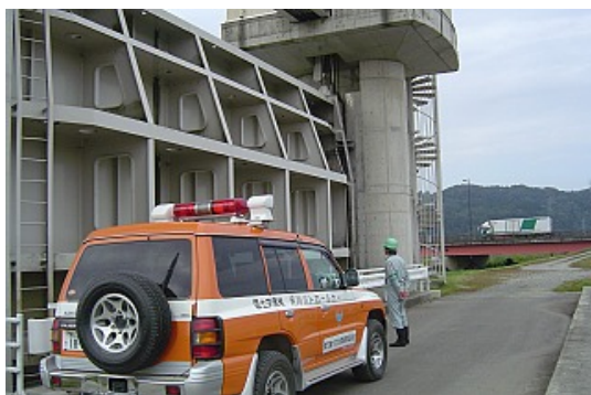
写真 5-3 河川巡視の実施
