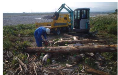
写真 5-6 流木等の処理
