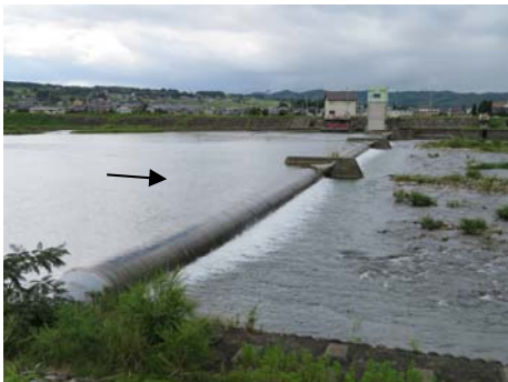
写真 3-40 井田川合口頭首工
