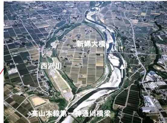
写真 3-13 神通川 20.6k 付近の状況
