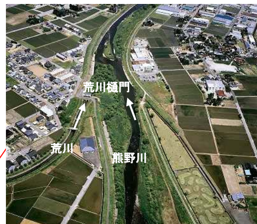
写真 3-29 熊野川 2.6k 付近の状況
