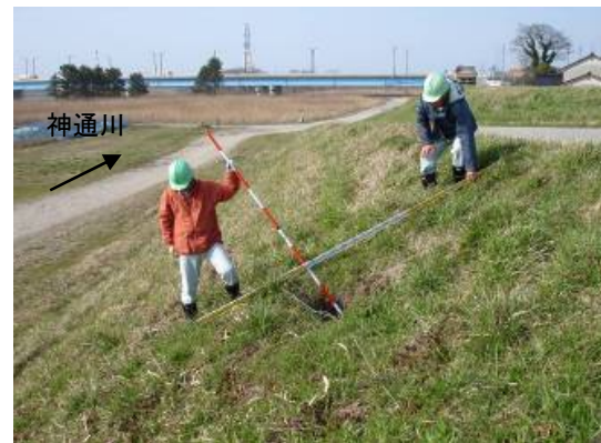
写真 3-10 平常時の巡視・点検状況
