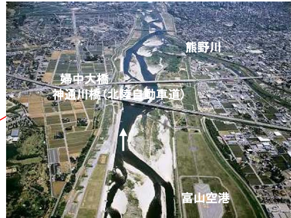
写真 3-17 神通川 11.0k 付近の状況
