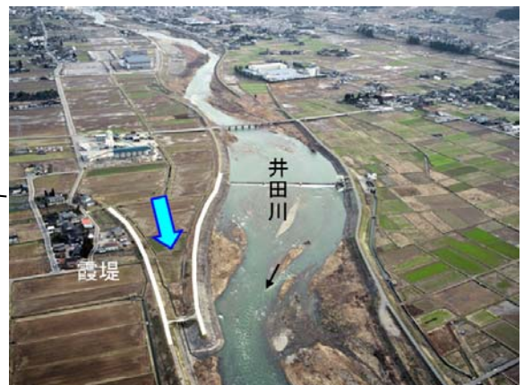
写真 3-7 井田川 11.7k 右岸の霞堤
