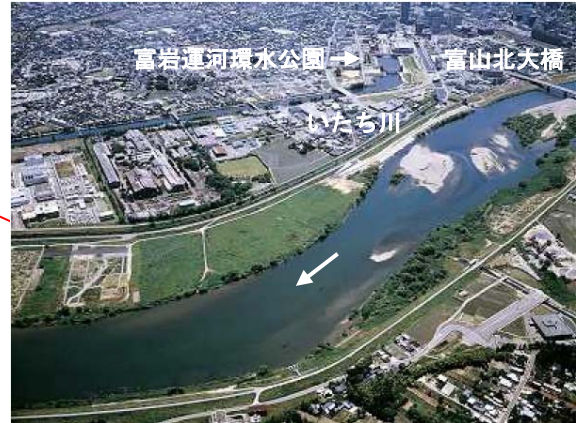
写真 3-21 神通川 6.0k 付近の状況
