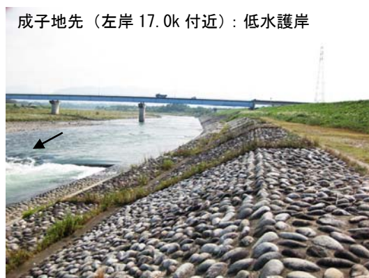
写真 3-3 急流河川対策実施例(低水護岸)
