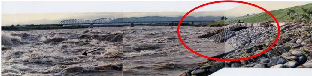
写真 2-25 S58.9 洪水(富山市成子の護岸欠壊堤脚洗掘状況)
