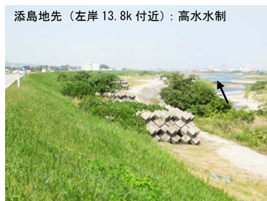
写真 3-4 急流河川対策実施例(高水水制)
