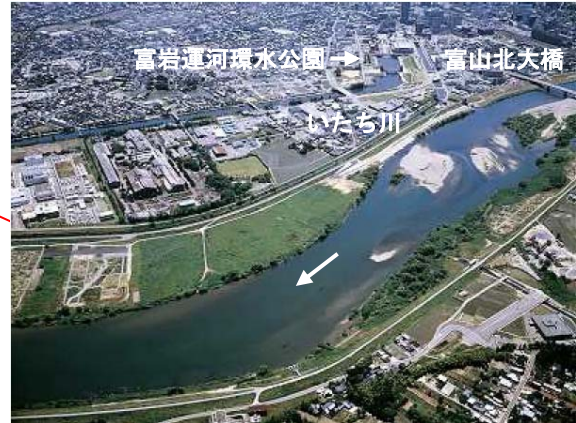
写真 3-21 神通川 6.0k 付近の状況
