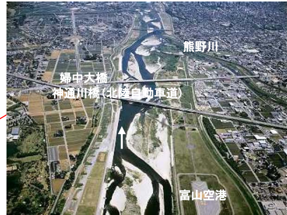
写真 3-17 神通川 11.0k 付近の状況
