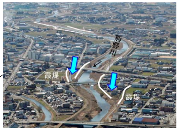
写真 3-6 熊野川 1.0k 付近の霞堤
