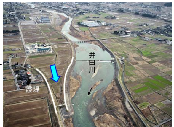
写真 3-7 井田川 11.7k 右岸の霞堤
