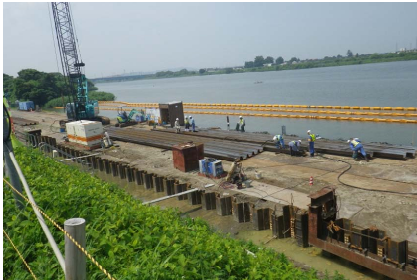
写真 3-5 耐震対策の実施例(神通川右岸 1.0k 付近)
