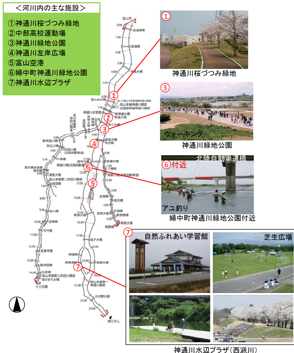
図 3-23 河川内の主な施設の状況
