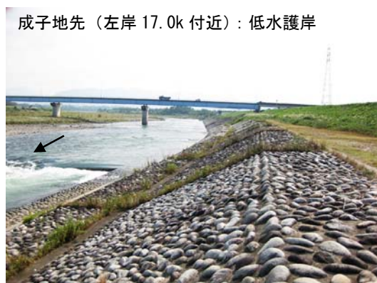
写真 3-3 急流河川対策実施例(低水護岸)
