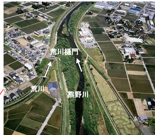
写真 3-29 熊野川 2.6k 付近の状況
