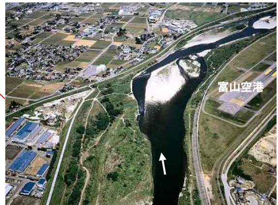
写真 3-18 神通川 14.0k 付近の状況
