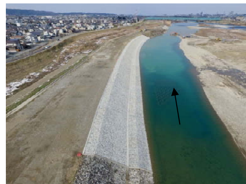
写真 5-1 急流河川対策実施例 （護岸の新設（神通川 10.4K 左岸））
