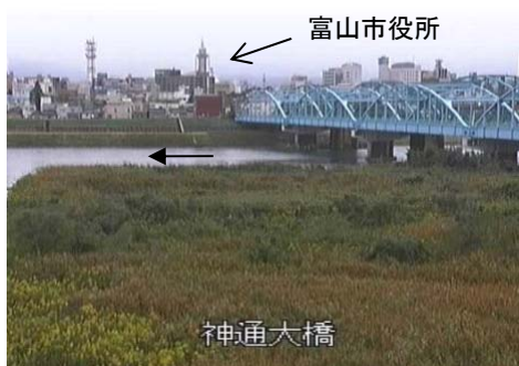
写真 2-26 平常時の様子(神通大橋)
