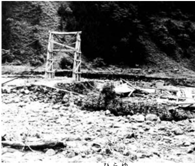
写真 2-22 S33.7 洪水(平湯川村上橋流失)
