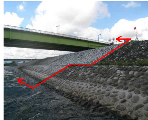
護岸の補修例 (表面Co)
