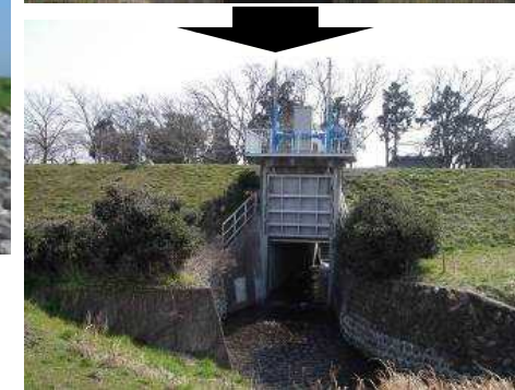
老朽化した施設の補修例 (松川舟通り水門) 26
