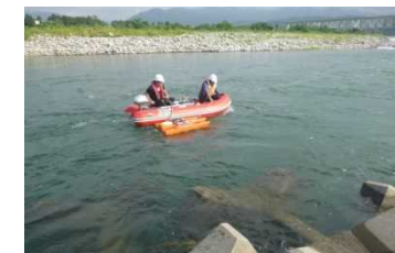
流速、水深調査 実施状況
