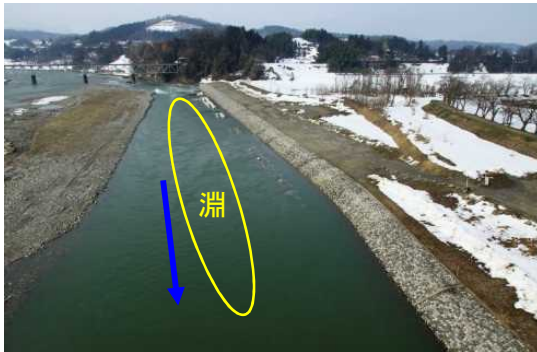
淵の形成（水制設置） 富山市西神通地先
