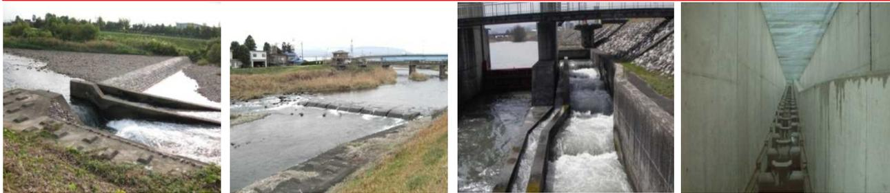
広田用水堰（階段式） 友杉用水堰（魚道はないが、段差が小さい） 井田川合口頭首工（階段式） 大坪用水堰（アイスハーバー式）
