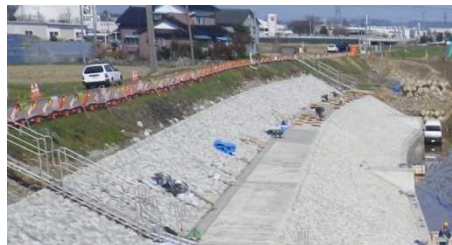
施工状況の例
