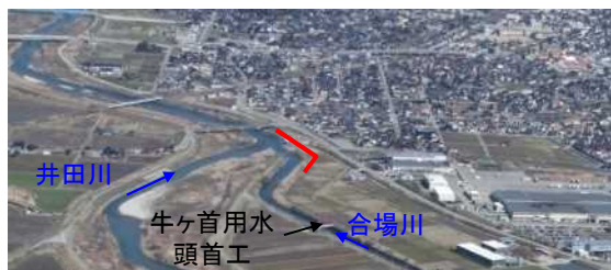
神通川 合場川合流点部の築堤範囲(H28)
