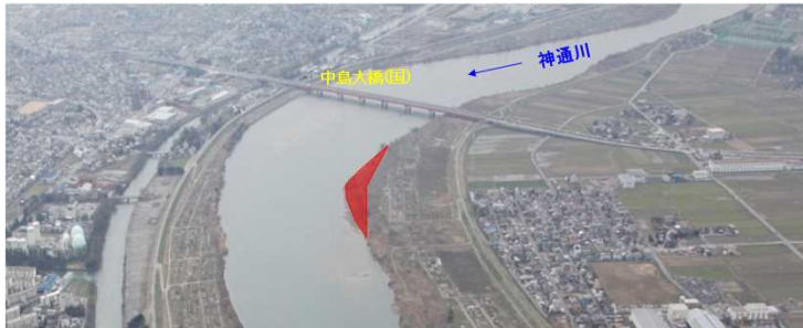
神通川 草島地区の河道掘削範囲
