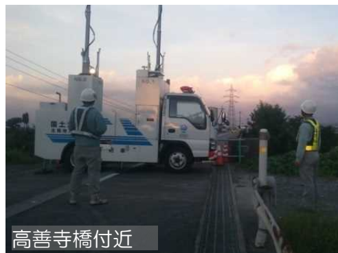
平成25年9月洪水でのポンプ排水及び照明車配備
