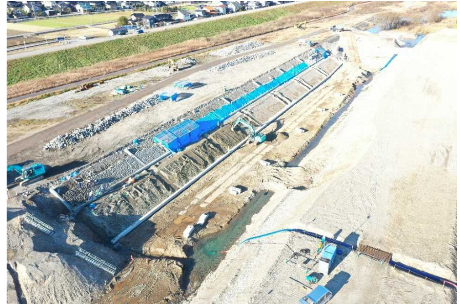
法覆護岸工 石張工の施工状況
