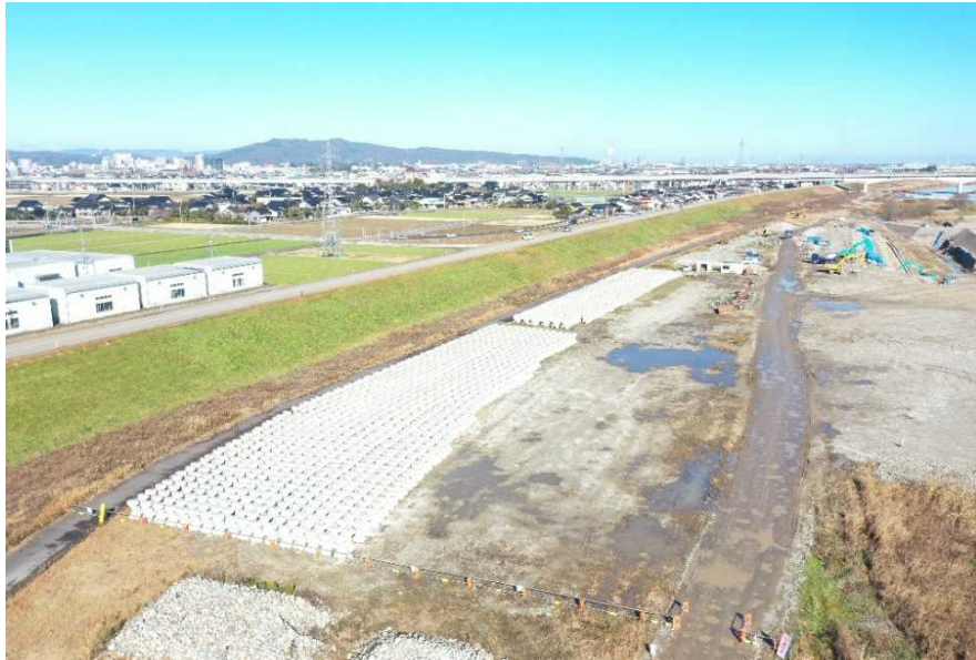
根固めブロックの製作完了(仮置き状況)
