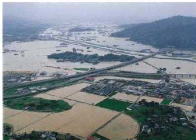
付録写真-3 長崎自動車道武雄IC付近浸水状況（平成21年7月）
