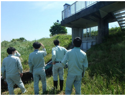
河川管理施設の点検
