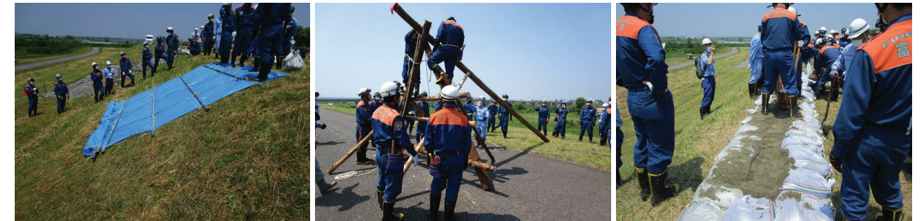
シート張り工 川倉工 積土のう工
