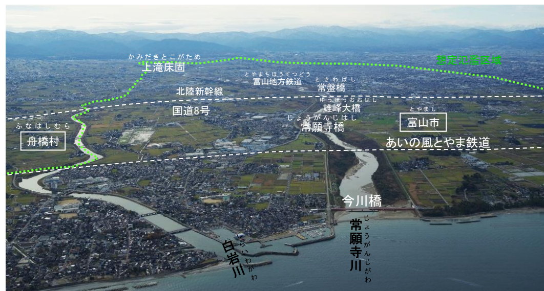
[常願寺川下流部の状況 (写真1-1)]
