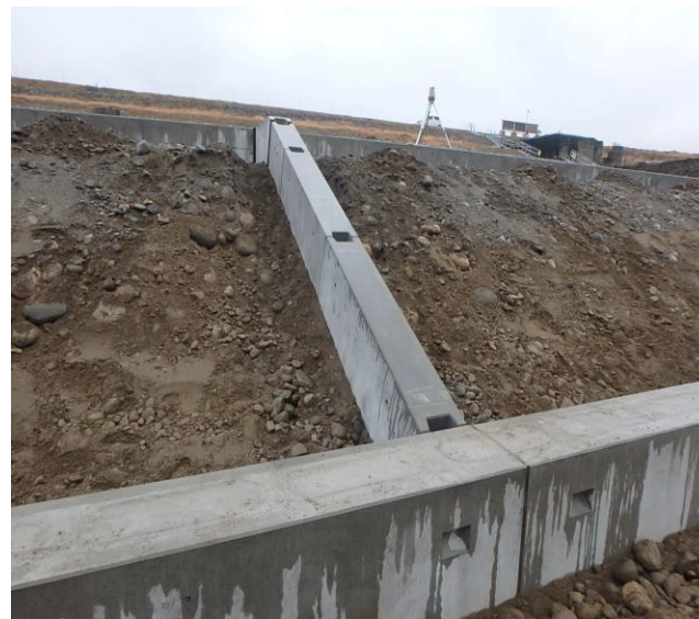
[護岸工事におけるプレキャスト製品の採用 (図6-1)]
