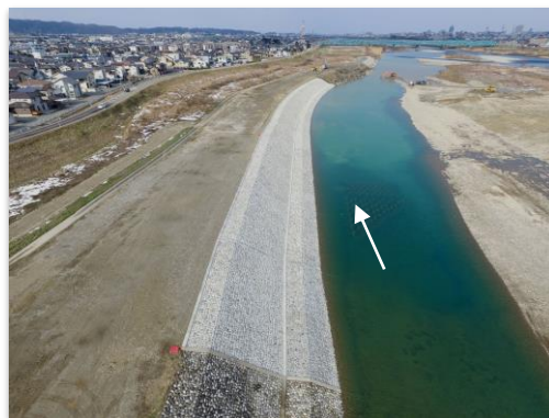
急流河川対策実施例 (護岸の新設(神通川10.4K左岸))
