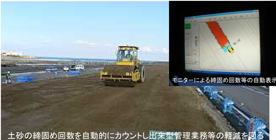
[築堤工事における情報化施工の取り組み]
