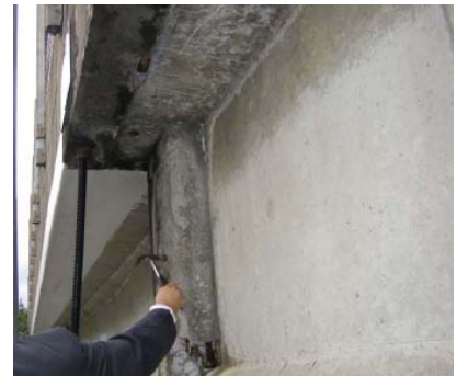
打音調査状況
