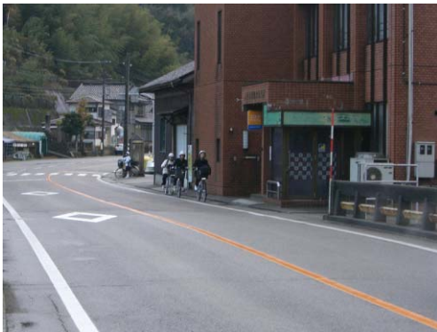
【整備前の写真】
