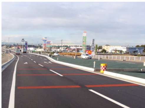
減速を促す注意喚起路面標示
