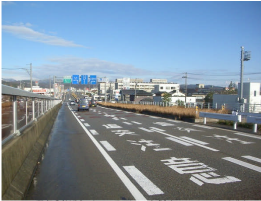
減速を促す注意喚起路面標示
