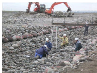
通水後の河床材料の調査
