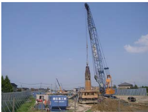
【場所打ち杭施工状況】
