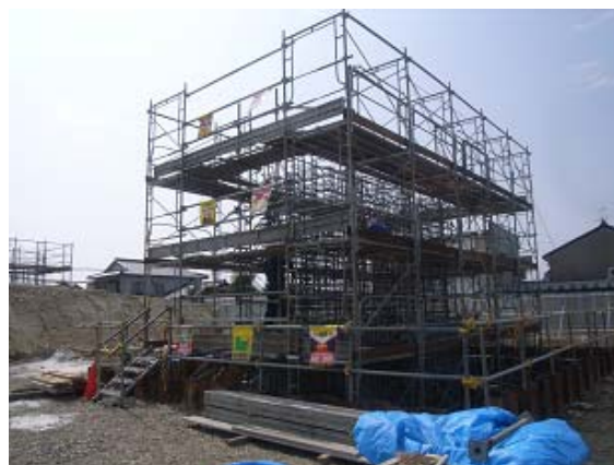
【鉄筋組立状況】
